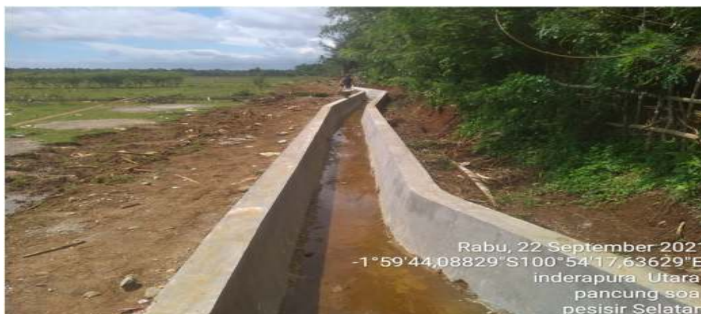
Gambar 3.16 Rehabilitasi Saluran DI Damar Rumpit
