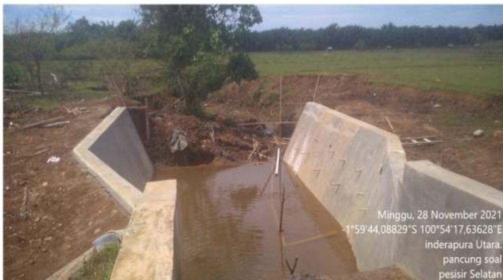
Gambar 3.15. Perbaikan Sayap Bendung Daerah Irigasi (DI) Damar Rumpit
