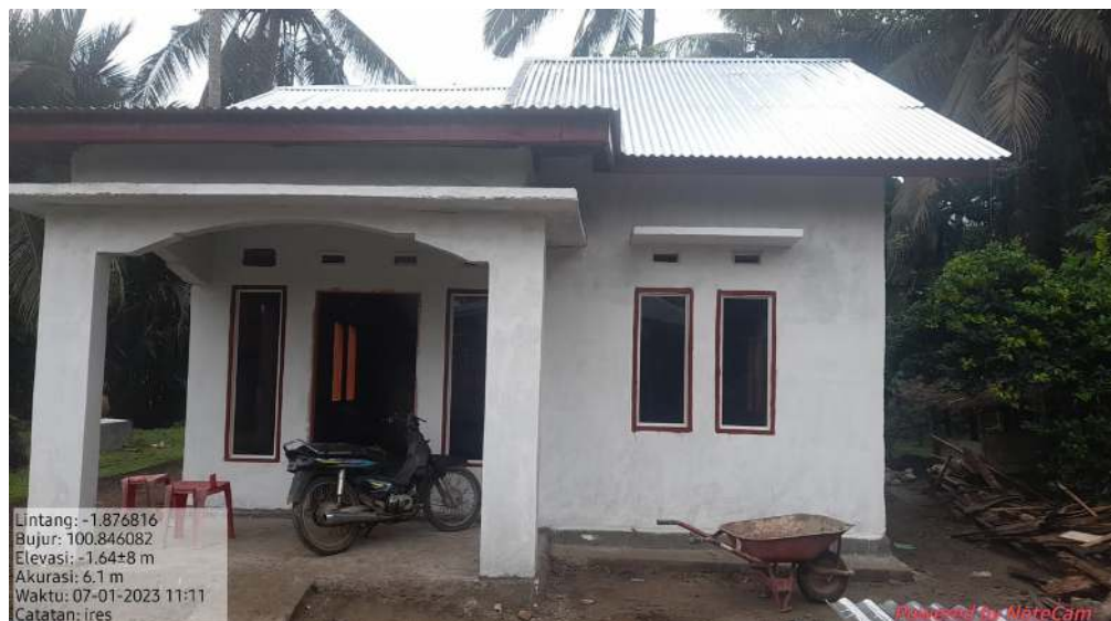
Rumah Layak Huni (Setelah di rehabilitasi)
